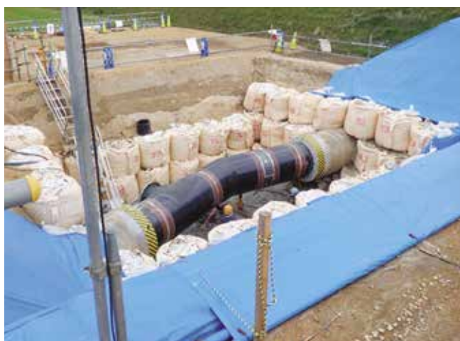
15工区改修状況（さぬき市）
