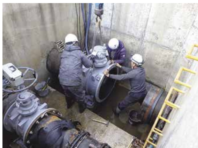
三郎池調整分水工整備状況（高松市）
