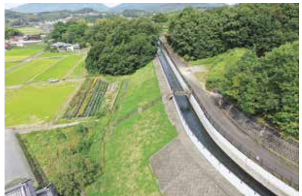
長野第3開水路法面
