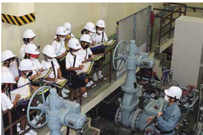
東部幹線揚水機場内の見学
