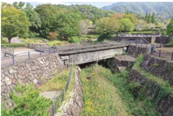
長野川水路橋
