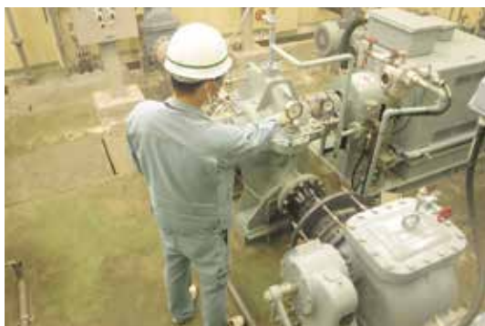
揚水機の点検
