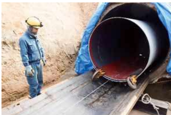
既設管内搬入状況
