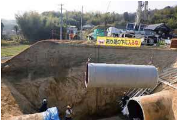
巻込み鋼管搬入状況
