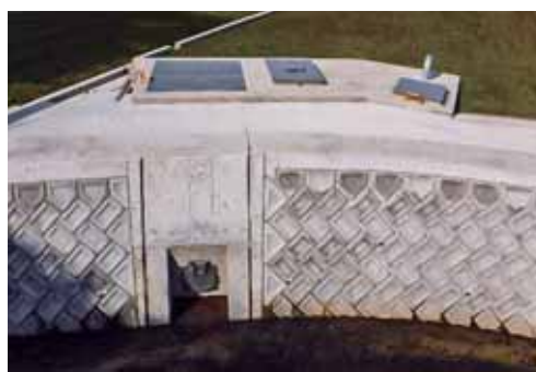
東長谷排泥工【施工後】
