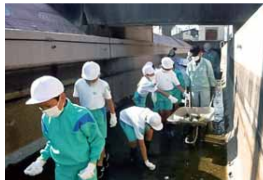
幹線水路内の清掃
