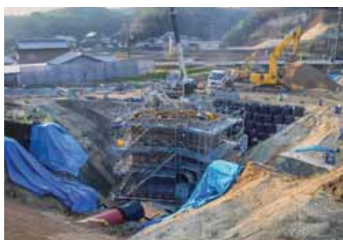
東長谷排泥工【施工中】
