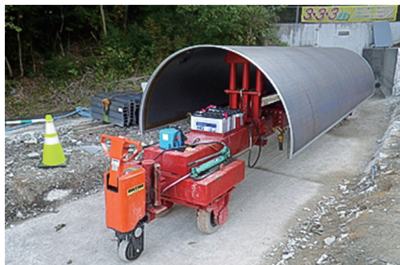
鋼板内張材搬入状況
