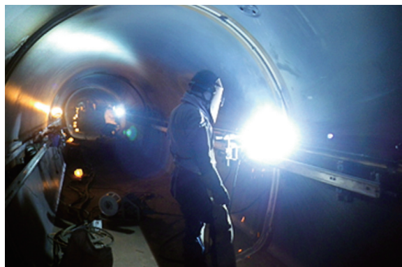
鋼板内張材溶接状況
