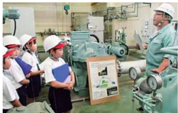
東部幹線揚水機場内の見学
