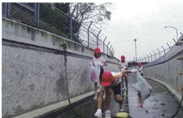
幹線水路内の清掃
