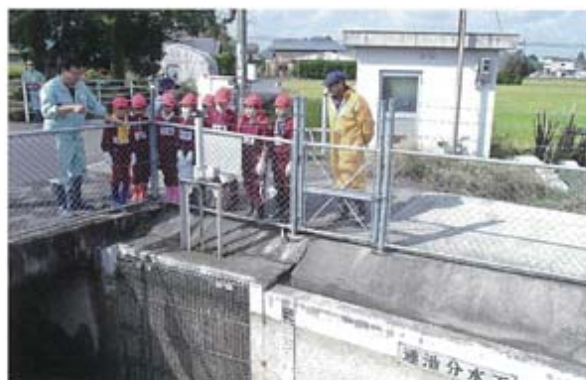
東部幹線蓮池分水工の説明
