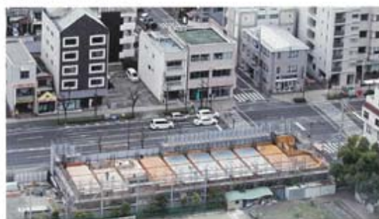
工事状況（H28.11.10時点） 1階・2階床部分の鉄筋工事
