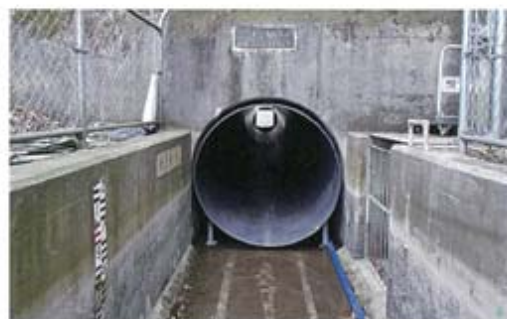
▲鋼管据付状況
