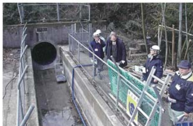
小松トンネル視察
