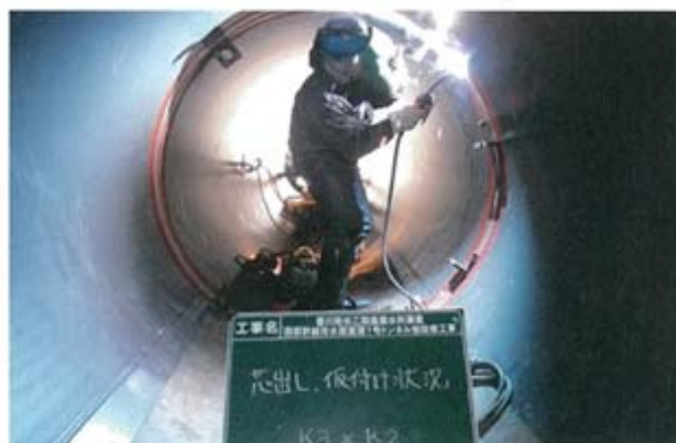
鋼管接合部の溶接状況
