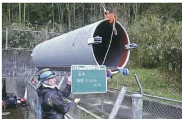
開水路内へ鋼管の吊り込み状況
