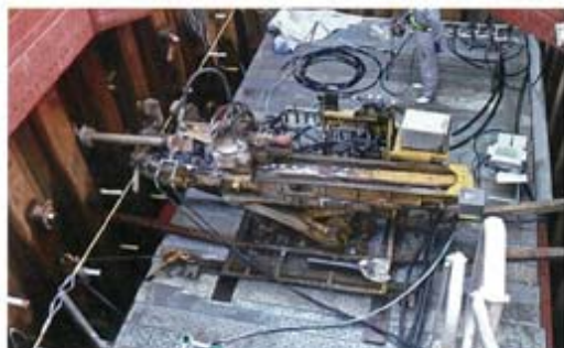
▲恒久グラウト注入状況
