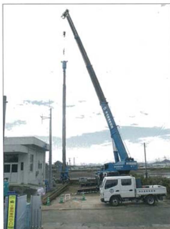
仮設鋼矢板の打設
