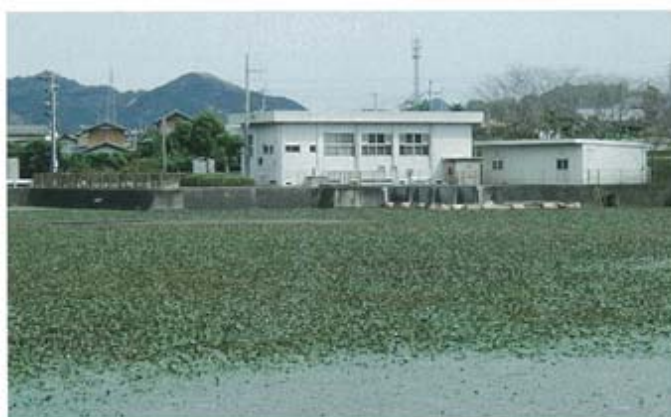
東部幹線揚水機場
