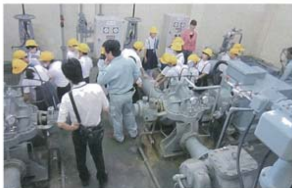
東部幹線揚水機場内ポンプ室の説明
