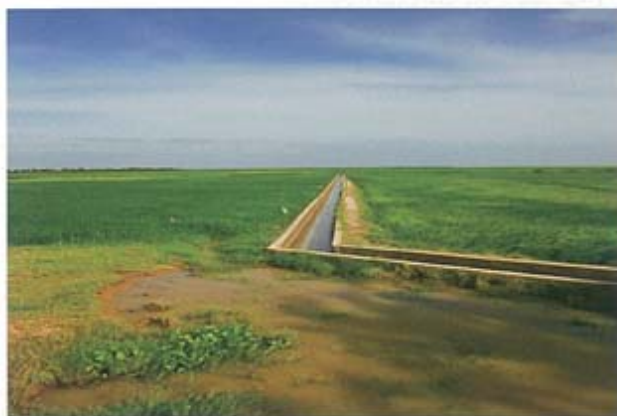
一望4千haの水田風景とJICA支援水路 雨季には2mほど冠水
