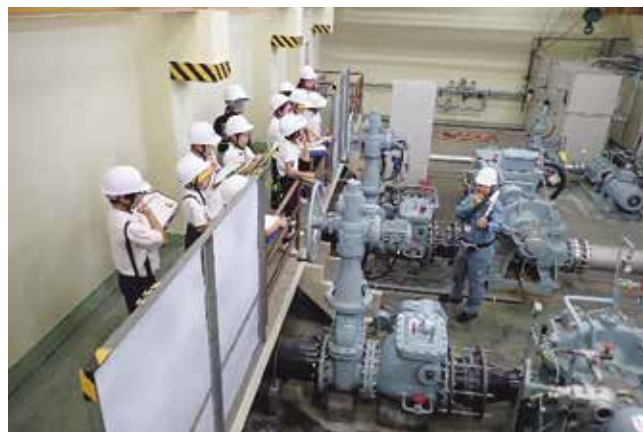
東部幹線揚水機場内の見学
