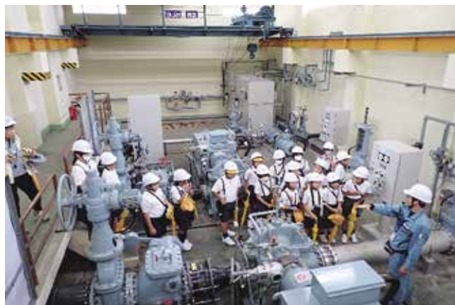
東部幹線揚水機場内の見学
