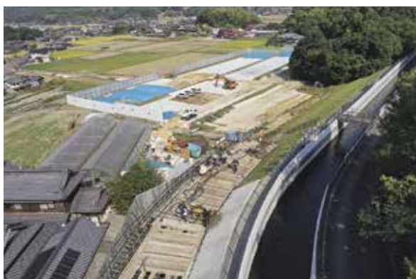
長野第3開水路
